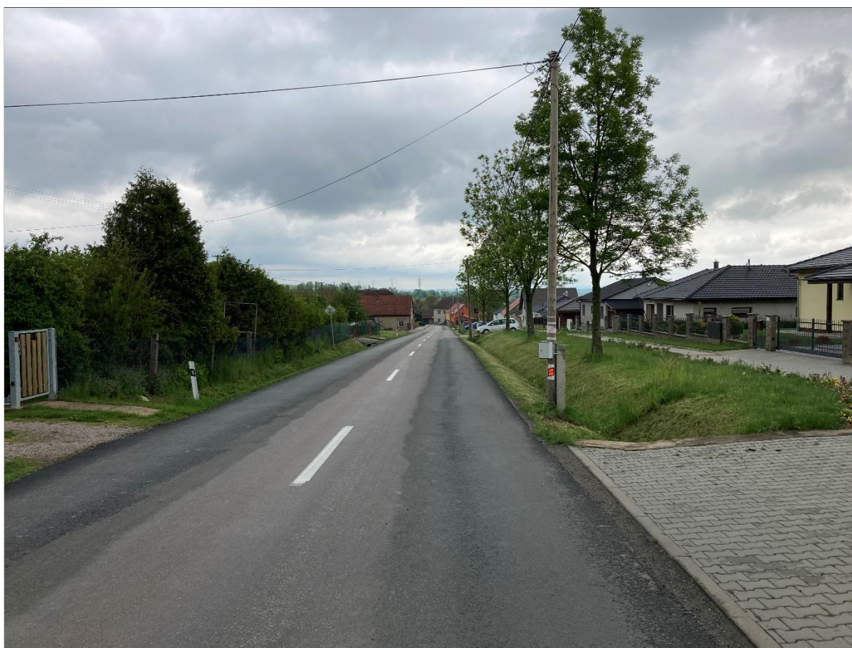
Obr. 4: Fotografie instalace radaru
